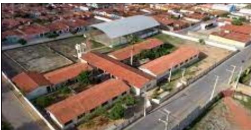
Figura 3 – Estrutura da Escola Simão Ângelo
